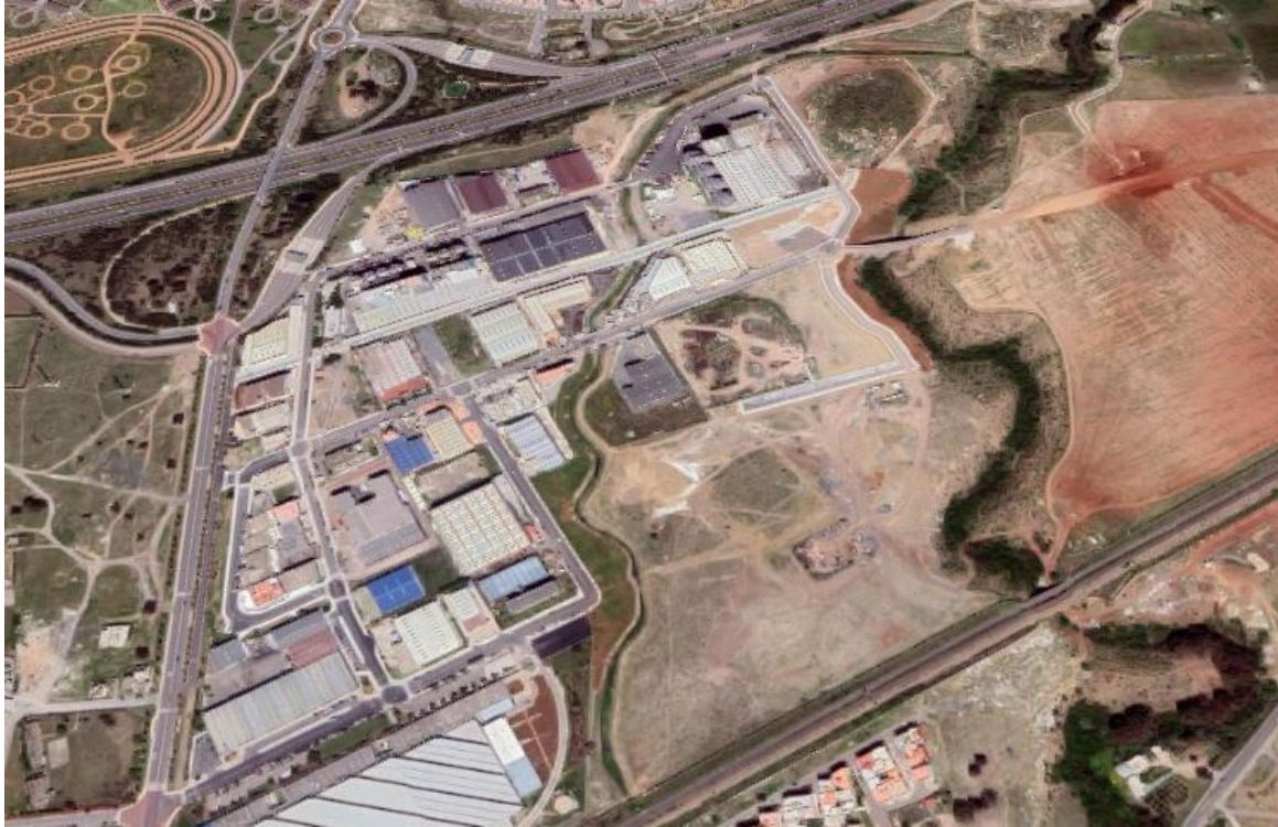
Ouvrages d'art situés à proximité d'une zone industrielle
